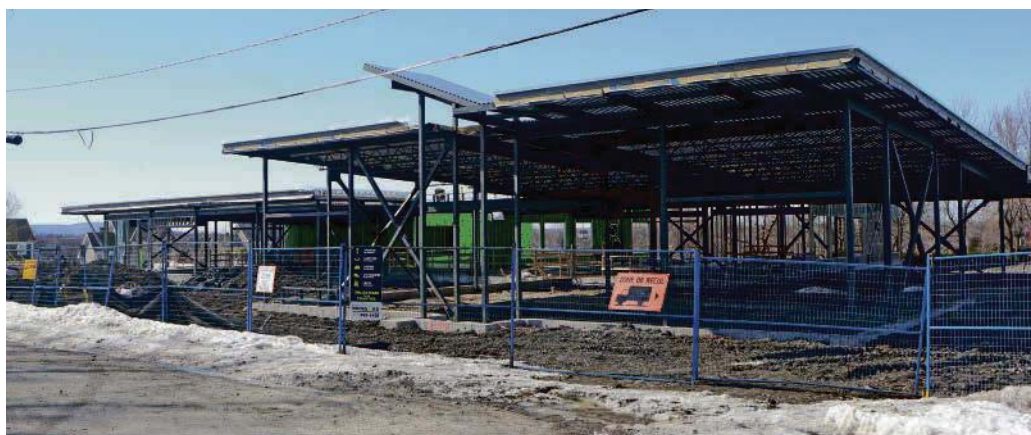
Le chantier de construction de la nouvelle école. Photo Robert Gosselin | L'Œil Régional ©
