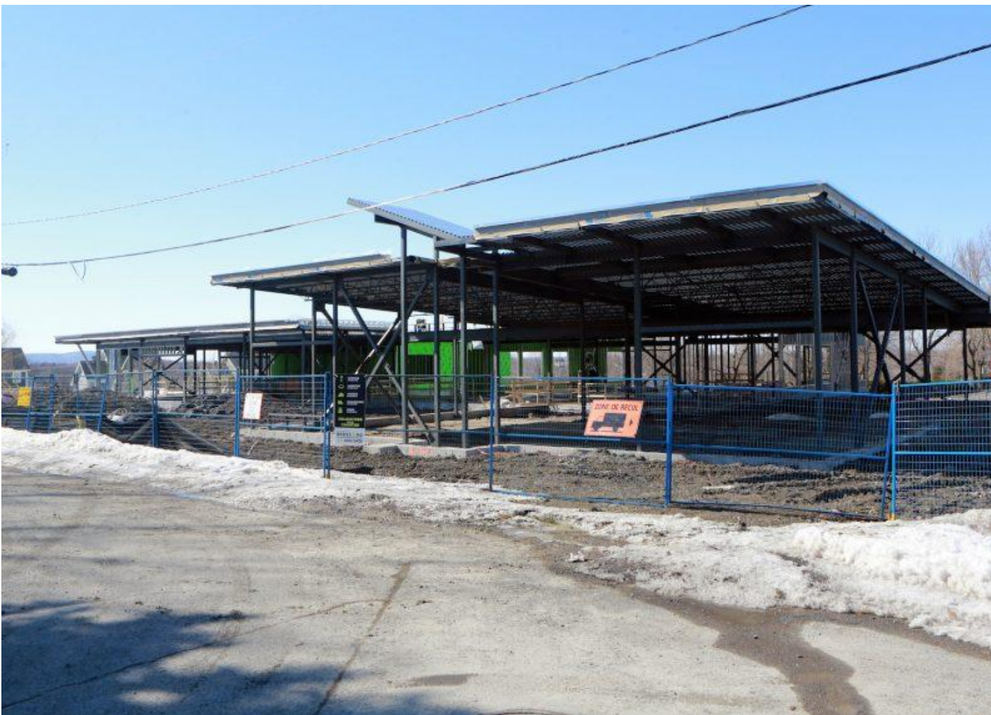
Le chantier de construction de la nouvelle école. Photo Robert Gosselin | L'Œil Régional ©
