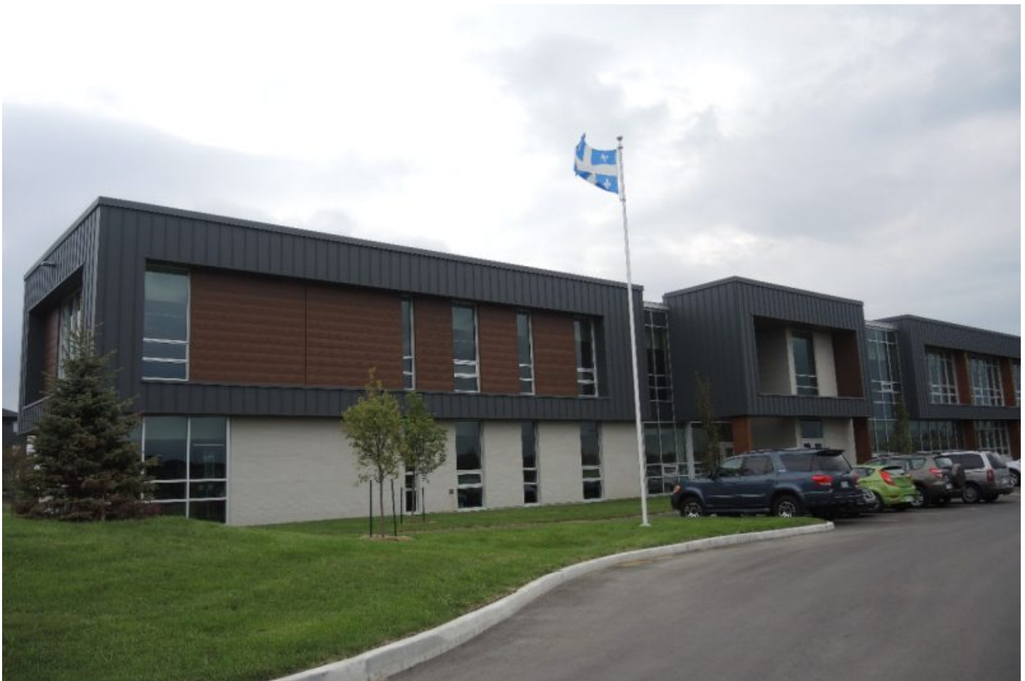
La nouvelle école de Chambly.
