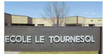
Les dommages sont mineurs et se limitent à des marques noires sur le mur extérieur. PHOTO ARCHIVES
