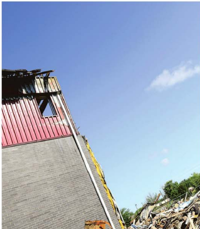
La Commission scolaire des Patriotes procède au nettoyage du site de l'école La Farandole. Une palissade a été érigée afin d'éviter la propagation de particules d'amiante dans le voisinage. PHOTO TC MEDIA - YANNCANNO.COM
