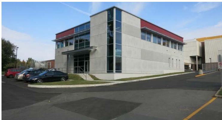
Le nouveau centre administratif de la CSP.
