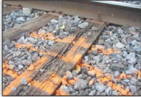
Le long de la voie ferrée à cette intersection à Varennes, les nouvelles traverses s'empilent en attendant les travaux de réparation.
