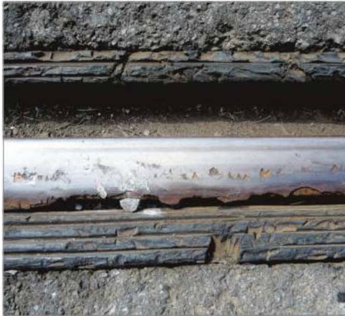
L'usure sur ces rails semble inquiétante, mais est normale.
