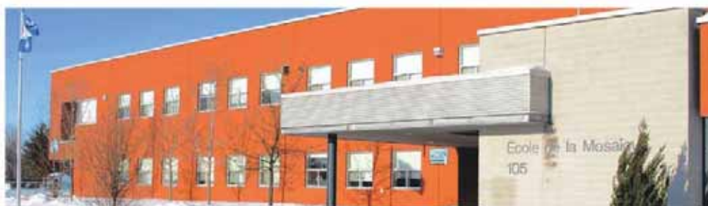
L'agrandissement permettra d'ajouter 14 classes au préscolaire et au primaire, ainsi qu'un service de garde. (Photo : Archivée)
