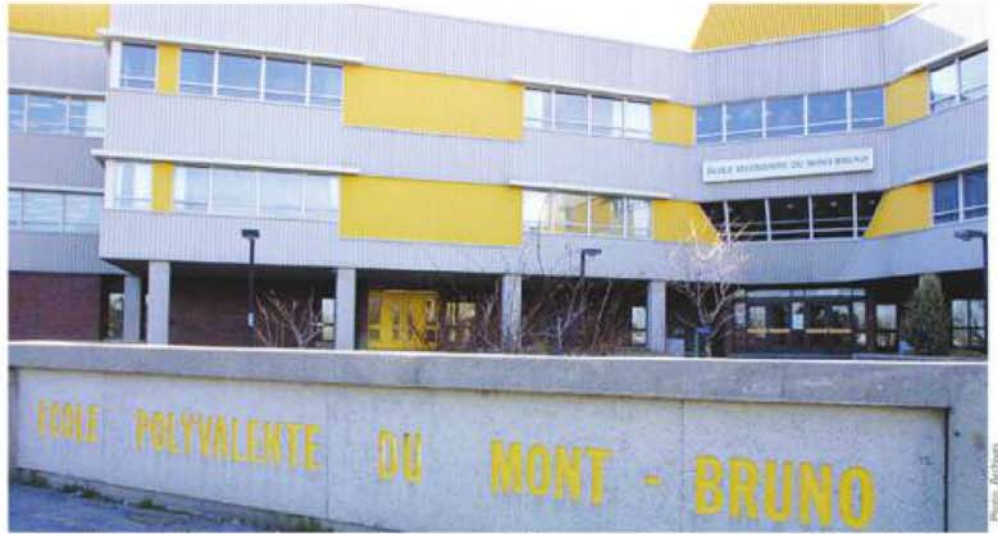
La Commission scolaire des Patriotes souhaite procéder à la construction d'une annexe derrière l'école du Mont-Bruno afin d'y relocaliser ses employés du service des ressources matérielles.
