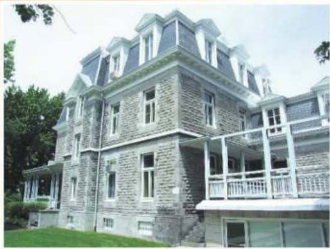
Au centre Mgr-Poissant, il faudra remplacer quelques tuiles acoustiques de plafond.
